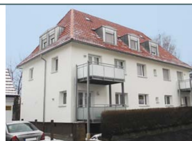
Titelbild: Tobias-Mayer-Straße 61 frisch renoviert
